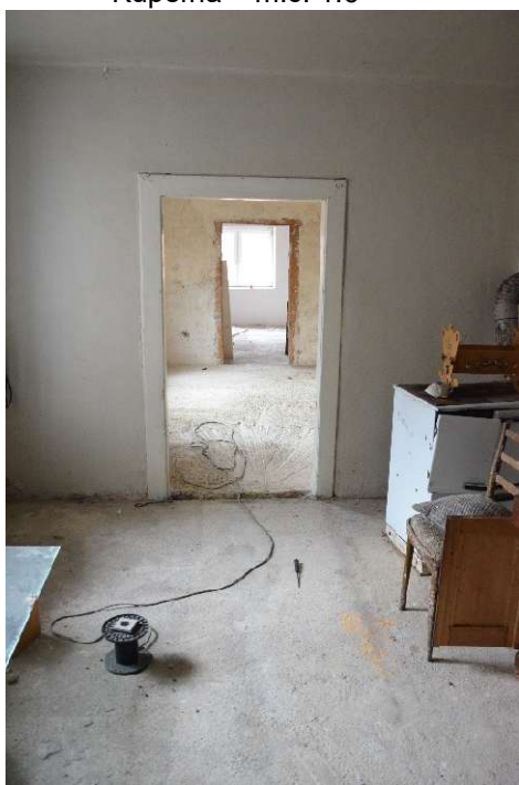
Pohľad z obývačky ( m.č. 1.3) „cez“ otvory do izieb m.č. 1.2 a 1.1.
