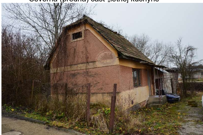
Severný pohľad (od ulice)
